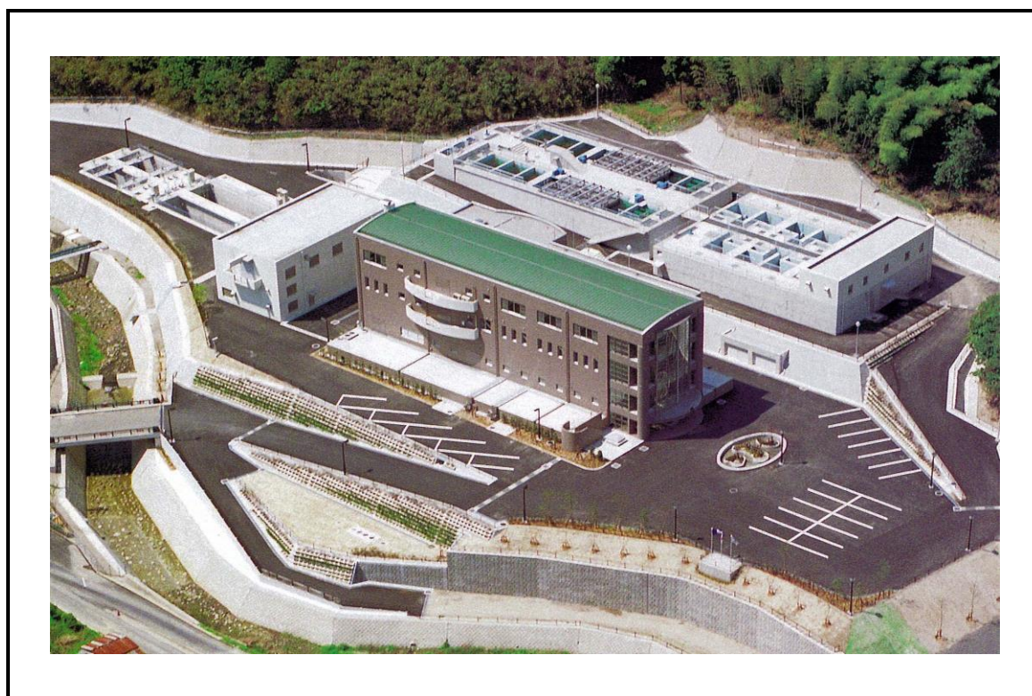
湯の川内浄水場
